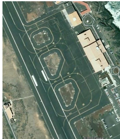
Ilustración 2.6.- Plataforma de estacionamiento
