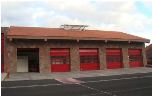
Ilustración 2.11.- Edificio de Servicios
