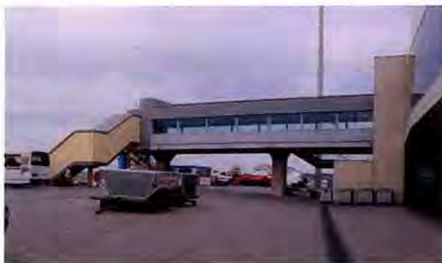
Ilustración 2.13.-Aspecto de uno de los cuatro diques del bloque principal del Edificio Terminal
