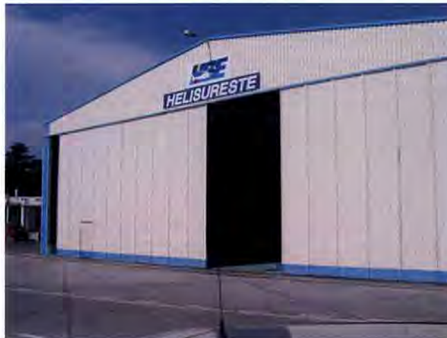
Ilustración 2.21.- Hangar de helicópteros
