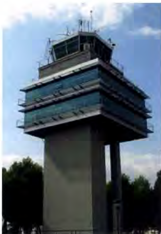
Ilustración 2.23.- Torre de Control del Aeropuerto de Valencia
