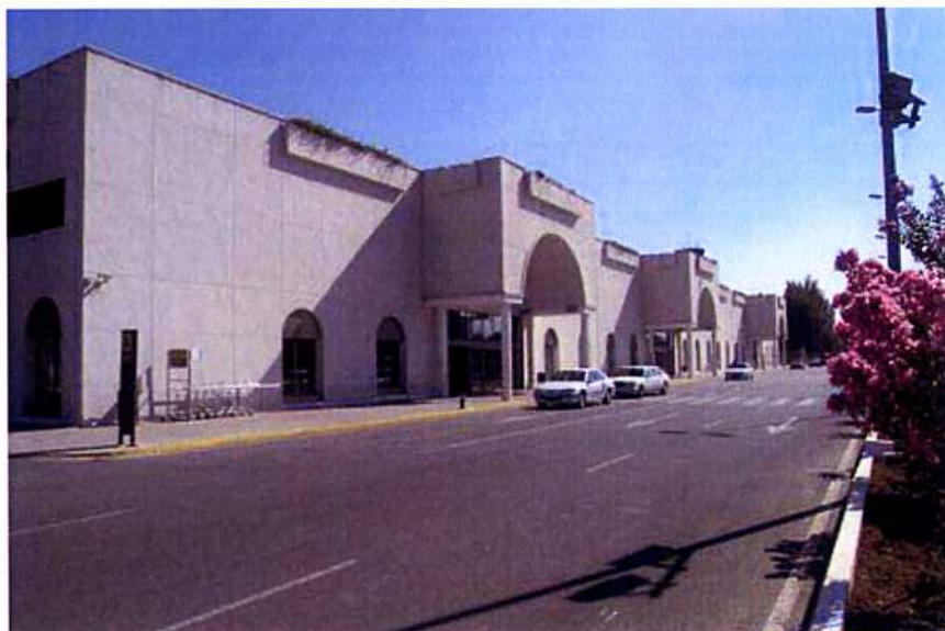
Ilustración 1.3.- Fachada principal del Edificio Terminal de pasajeros
