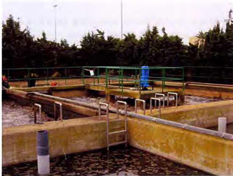
Ilustración 2.24.- Estación de aguas residuales (E.D.A.R.)
