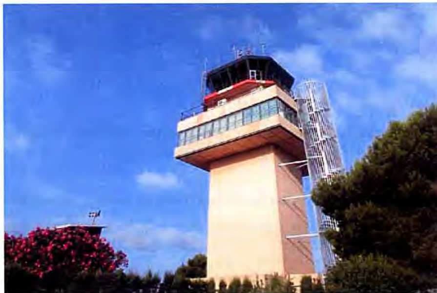
Ilustración 2.17.- Torre de Control
