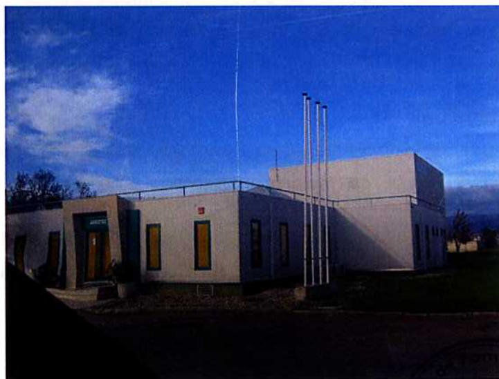
Ilustración 2.6.- Oficinas de Aerotec
