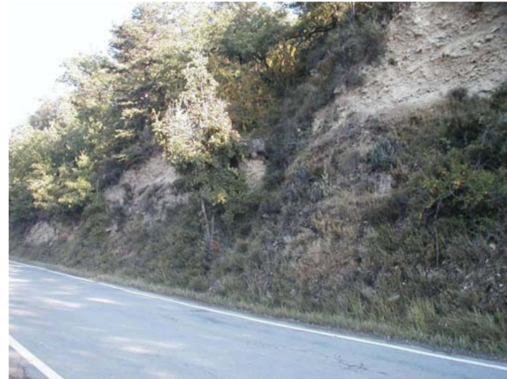
Foto 13: Vista de materiales (lutitas con cantos) de la unidad Flysch, en el corte de la carretera a la altura del PK 10+060.
