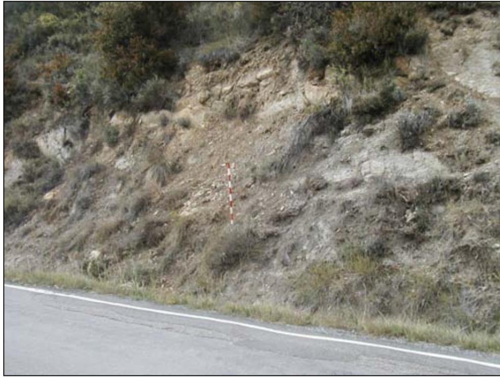
Foto 11: Vista de materiales (alternancia de areniscas y margas) de la unidad Flysch, en el corte de la carretera a la altura del PK 8+500.
