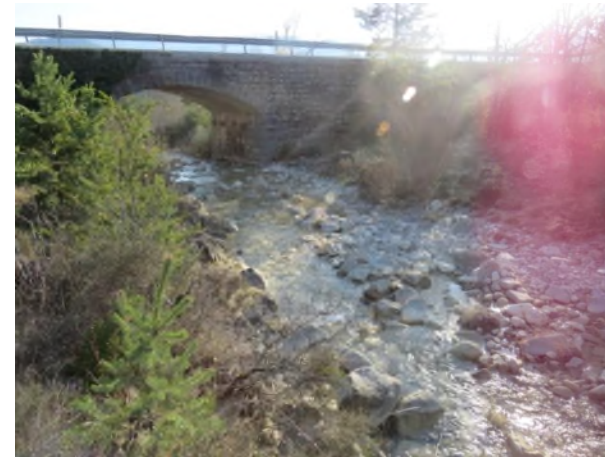
Puente de la carretera Bco. Espuña por A. García-Serrano
