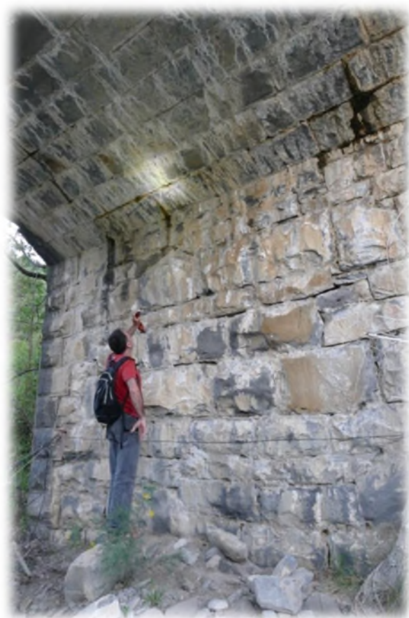
Figura 4.41. Revisión del puente que se prevé demoler, situado en el pk 5,700. Apenas se aprecian grietas aptas para murciélagos, por L. Lorente.
