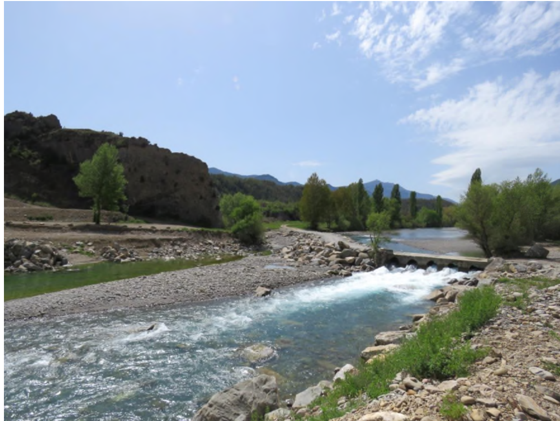
Figura 2.5. Acceso actual al pueblo de Jánovas en el río Ara, por A. García-Serrano.
