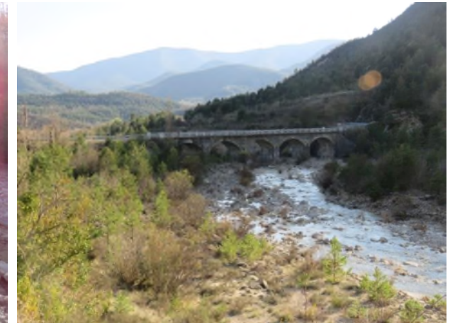
Puente de la carretera Bco. Las Guargas por A. García-Serrano
