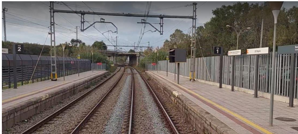
Figura 6. Final del apeadero de El Papiol en sentido Molins de Rei - Castellbisbal.
