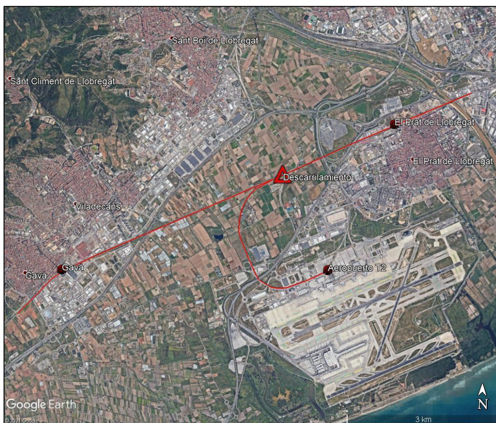
Imagen 1 Zona de la línea ferroviaria (fuente: Google Earth)
