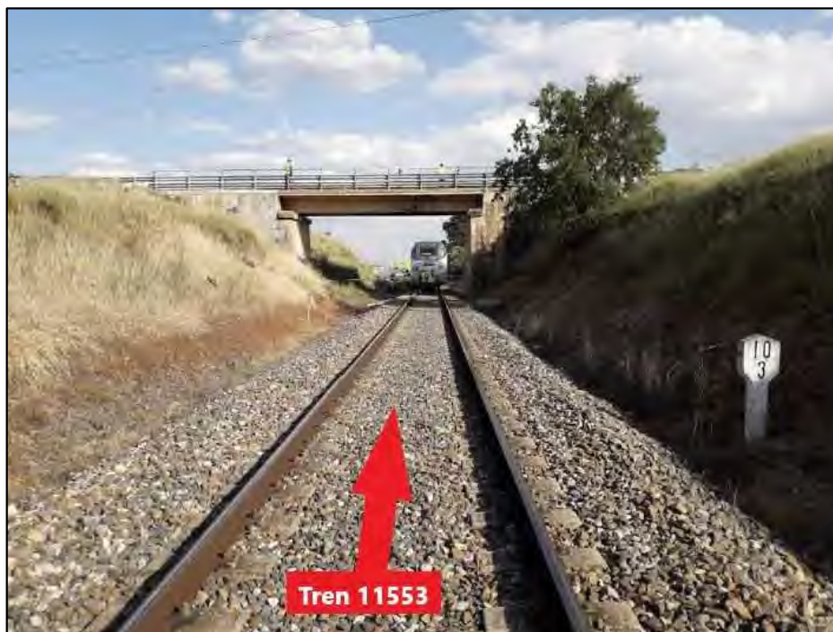
Imagen 9 Vista del paso superior desde el lado Orense
