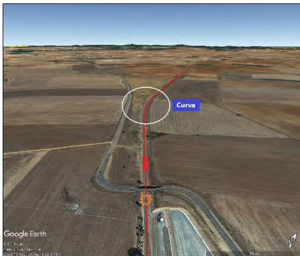
Imagen 6 Perspectiva aérea de la línea en la zona del accidente.
