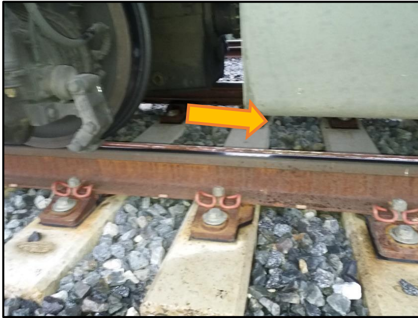
Imagen 7 Marcas en la zona interna de la aguja. La flecha indica la dirección del tren 04171.
