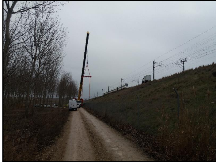
Imagen 4 Grúa utilizada para el encarrilamiento
