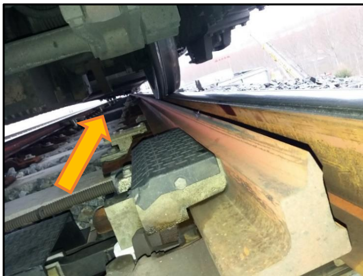
Imagen 5 Punta de la aguja curva. La flecha indica la dirección del tren 04171.
