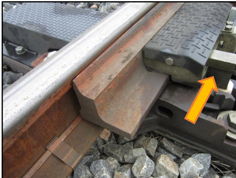
Imagen 8 Marcas en aguja recta. La flecha indica la dirección del tren 04171
