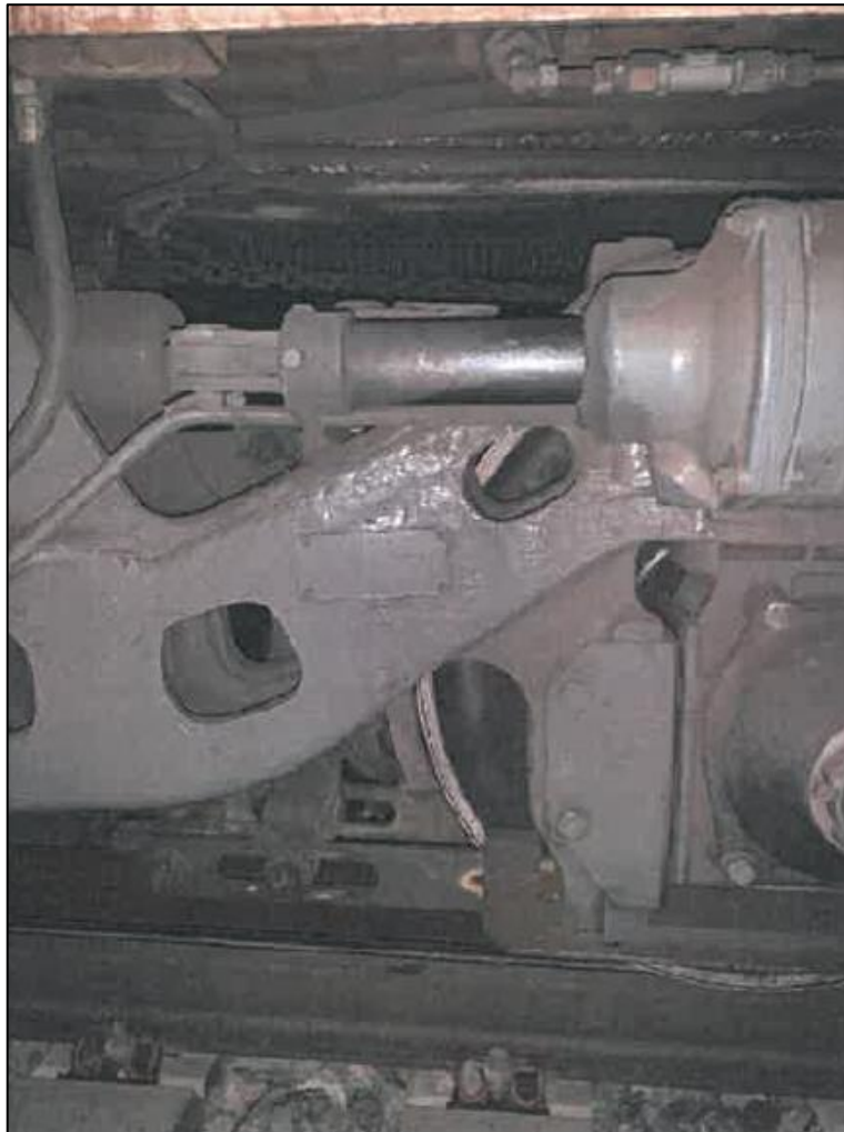
Figura 16 Conjunto rueda-zapata tras el accidente. Se aprecia el émbolo totalmente extendido y fuera del cilindro y la zapata sin entrar en contacto con la banda de rodadura de la rueda.
