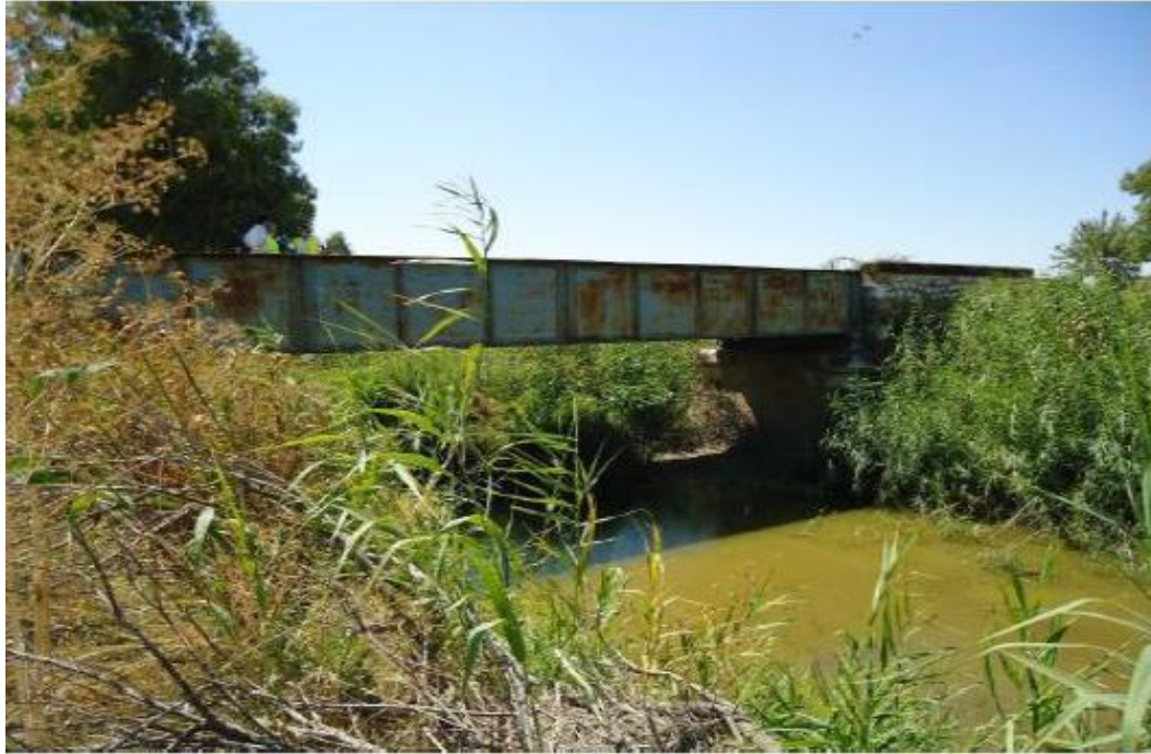
Trazado antiguo del puente sobre el arroyo Alameda visto desde aguas abajo. Actual vía verde. Fuente propia.
