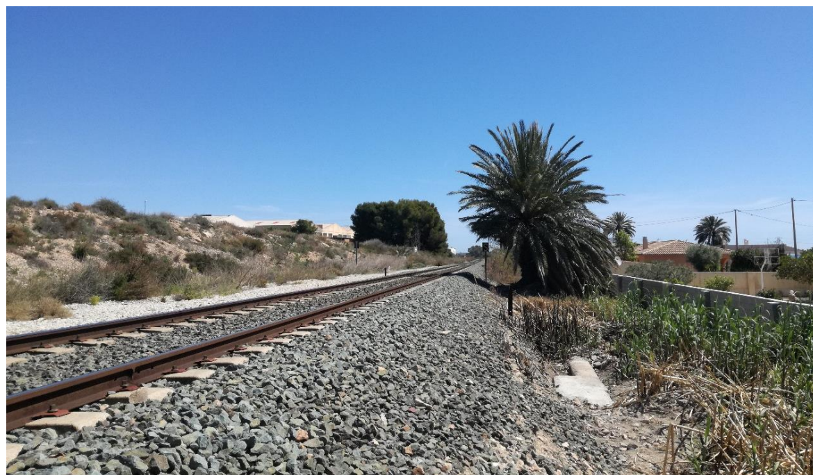
Foto 1: vista de la vía actual Alicante Término-Murcia
