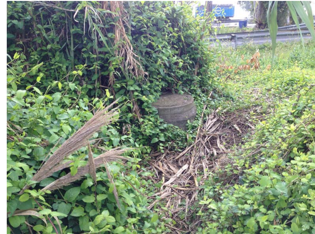
En la foto mostrada a continuación se muestra la cámara de registro existente de la tubería de abastecimiento entre la A-474 y la A-49:
