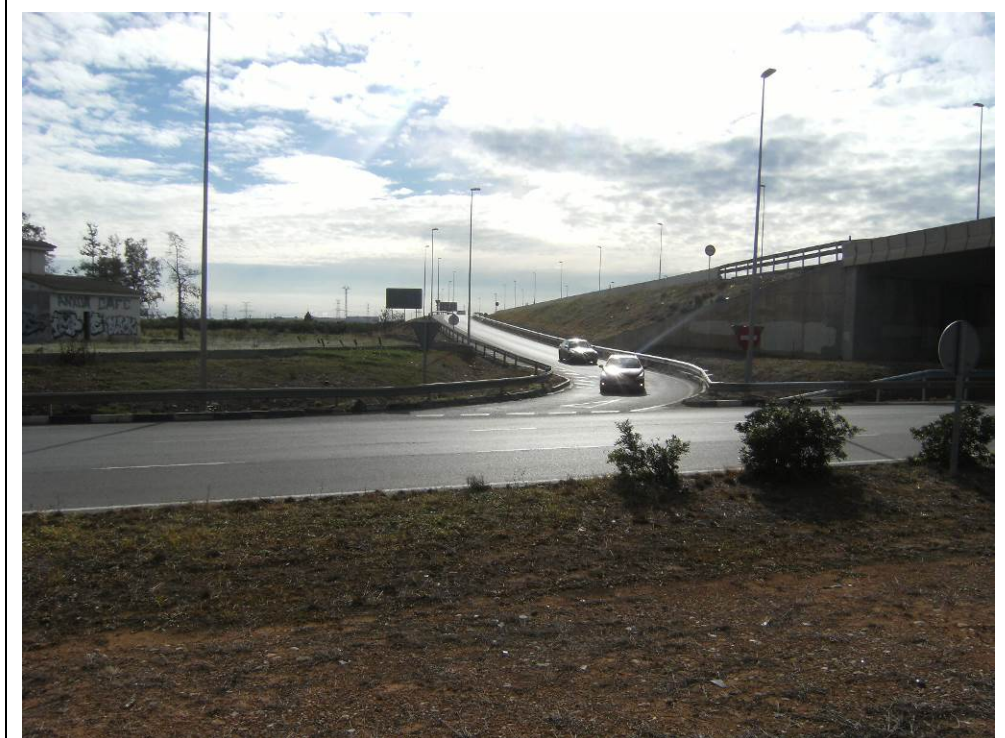
Foto 8. Vista general del enlace tipo glorieta con la N-340 a distinto nivel.
