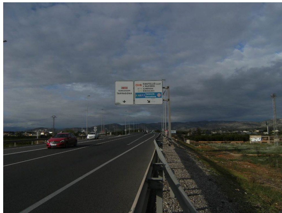
Foto 6. Inicio del ramal de deceleración de la N-340 donde se observa la banderola de salida inmediata.
