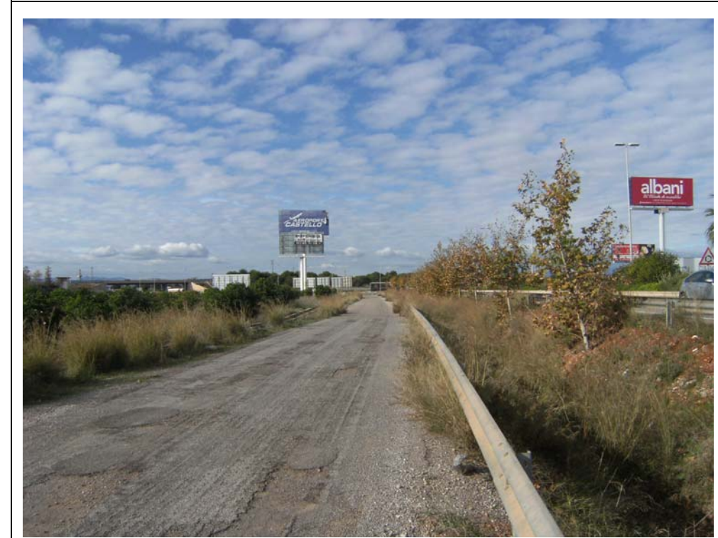
Foto 12. Camino Cuadra la Torta con la cuneta en tierras a reponer en su margen derecho.
