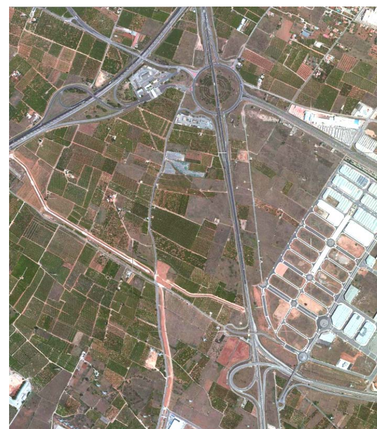
Figura 1. Fotografía aérea del emplazamiento de la actuación de la N-340
