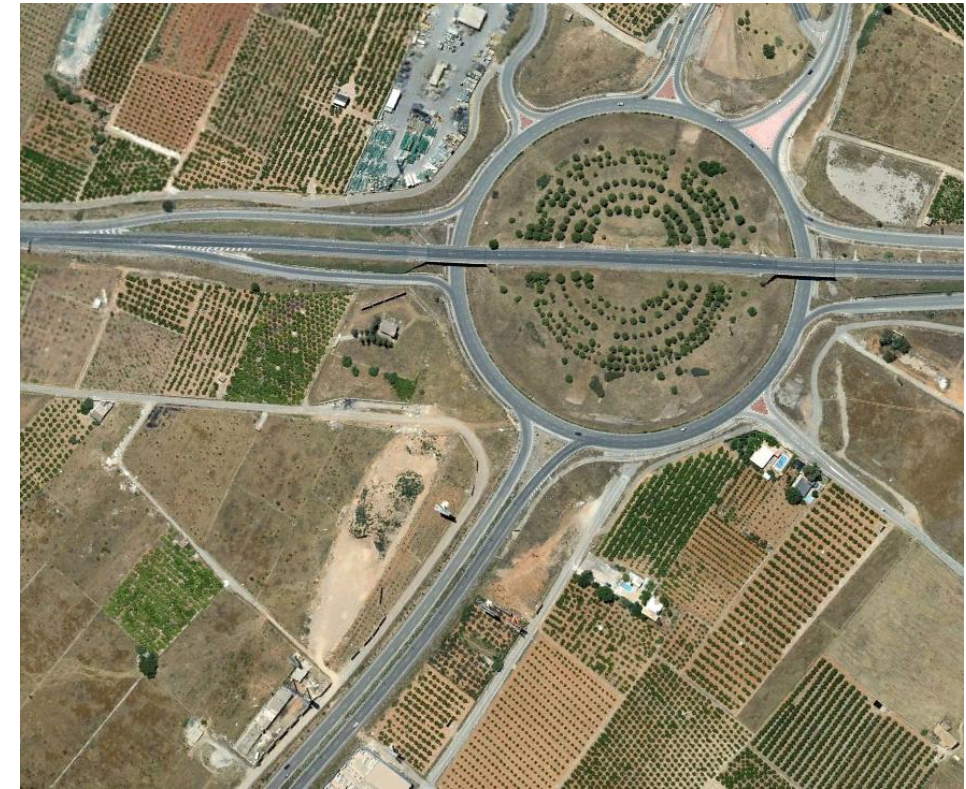
Ilustración 1: Situación de la actuación en el carril de trenzado y ramal directo entorno al P.K. 974+000 de la N-340.
