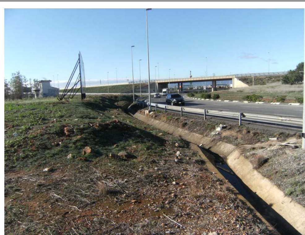
Foto 9. Vista de la glorieta con la N-340 a distinto nivel.
