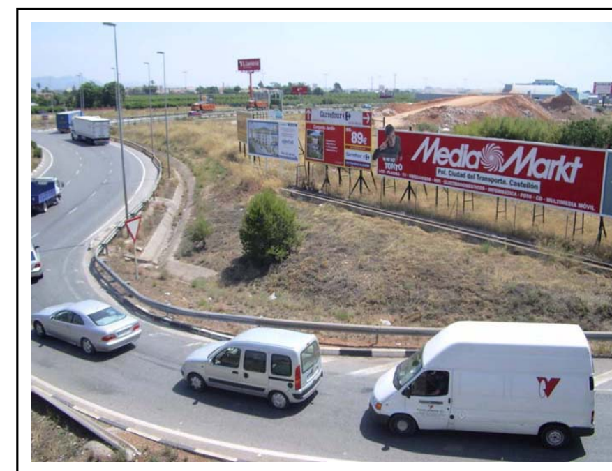
Foto 4. Acceso a la rotonda del enlace. Vista de las retenciones. Zona a ampliar a dos carriles en la boquilla.
