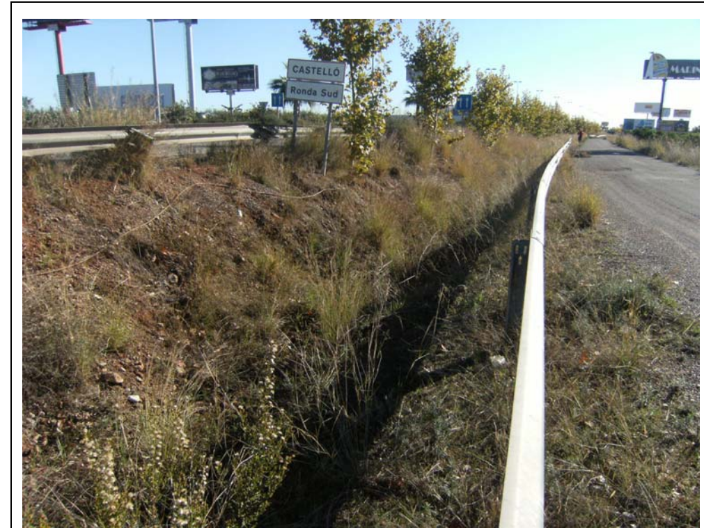
Foto 11. Cuneta sin revestir situada entre la Ronda Sur de Castellón y el camino.
