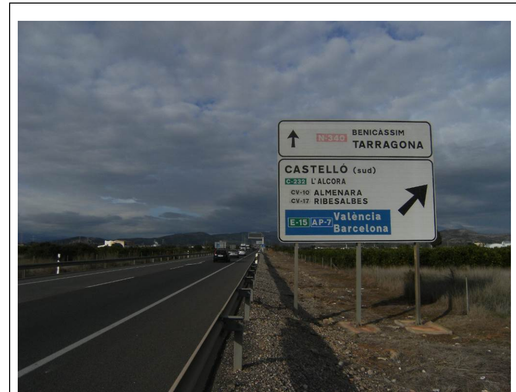
Foto 3. Cartel de preaviso de aproximación a enlace en margen derecha de la N-340.
