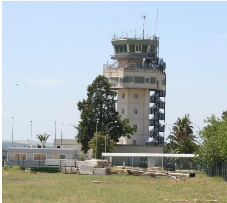
Ilustración 2.16.- Torre de control
