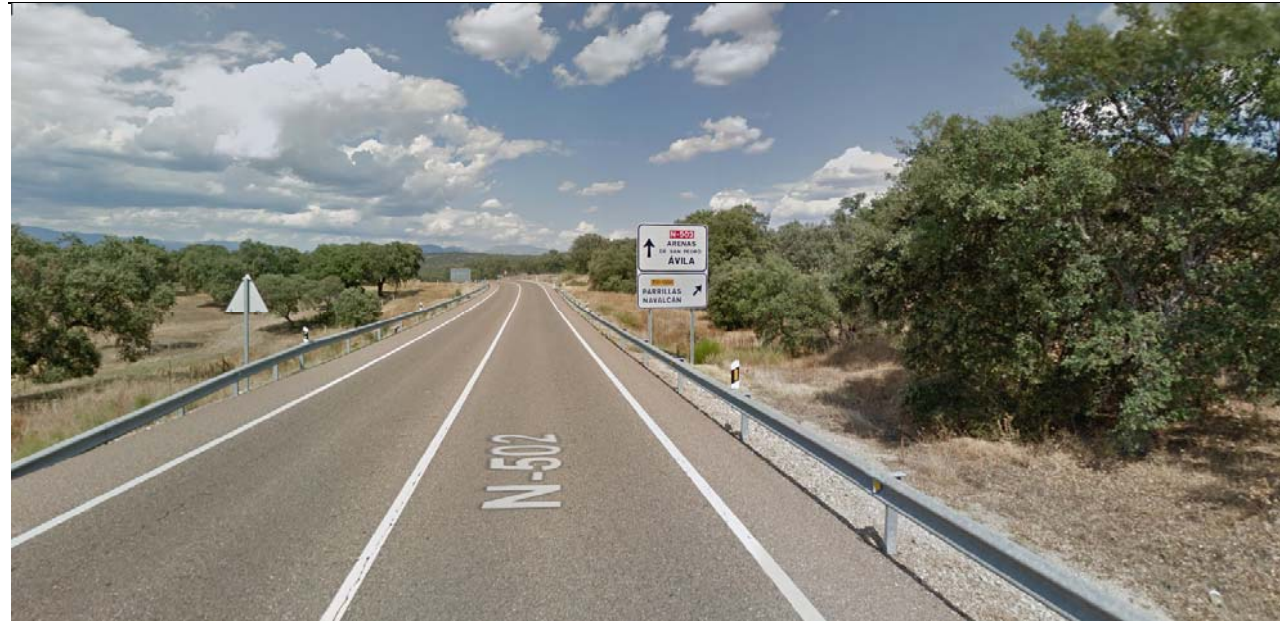
Intersección de Parrillas y Navalcán en sentido Ávila
