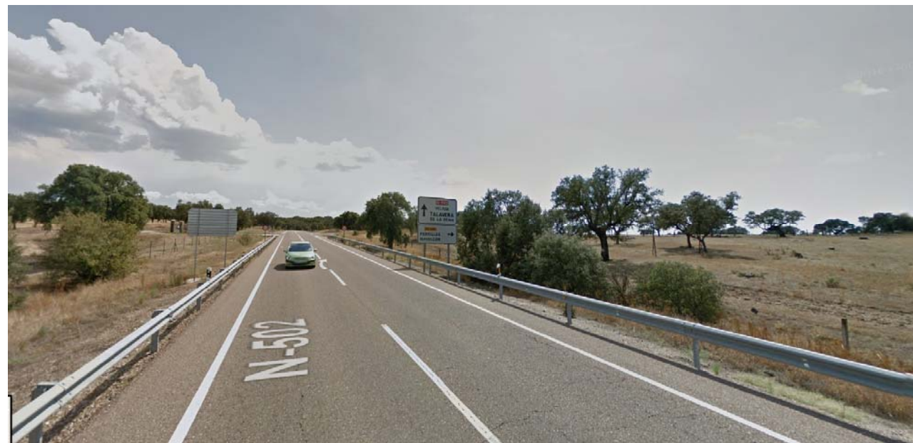
Intersección de Parrillas y Navalcán en sentido Talavera de la Reina
