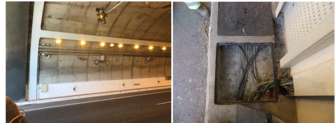
*Bandejas situadas en los hastiales (izquierda)- Cables bajo acera en Túnel Sur (derecha)
