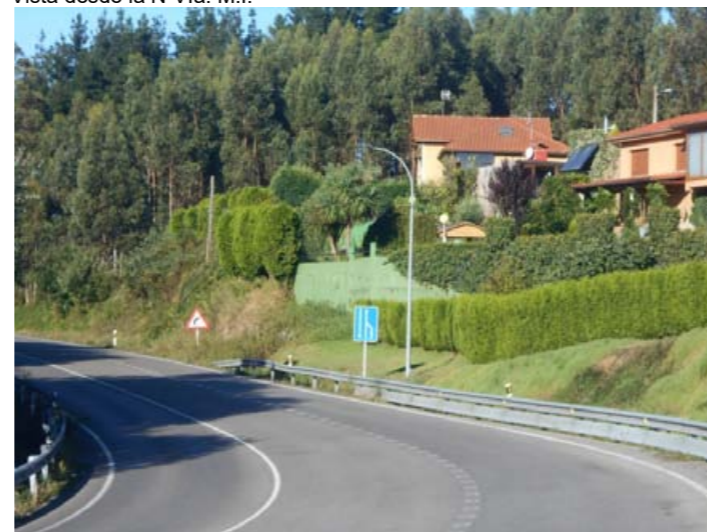
Vista de la N-VIa. P.K .579+740, Sentido creciente. Lugar escogido para la implementación de un carril central de espera
