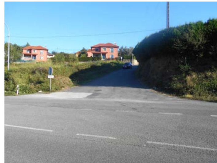
Vista Intersección, P.K .579+7400 M.D de la N-VIa. Acceso a Armea. Vista desde la N-VIa. M.I.
