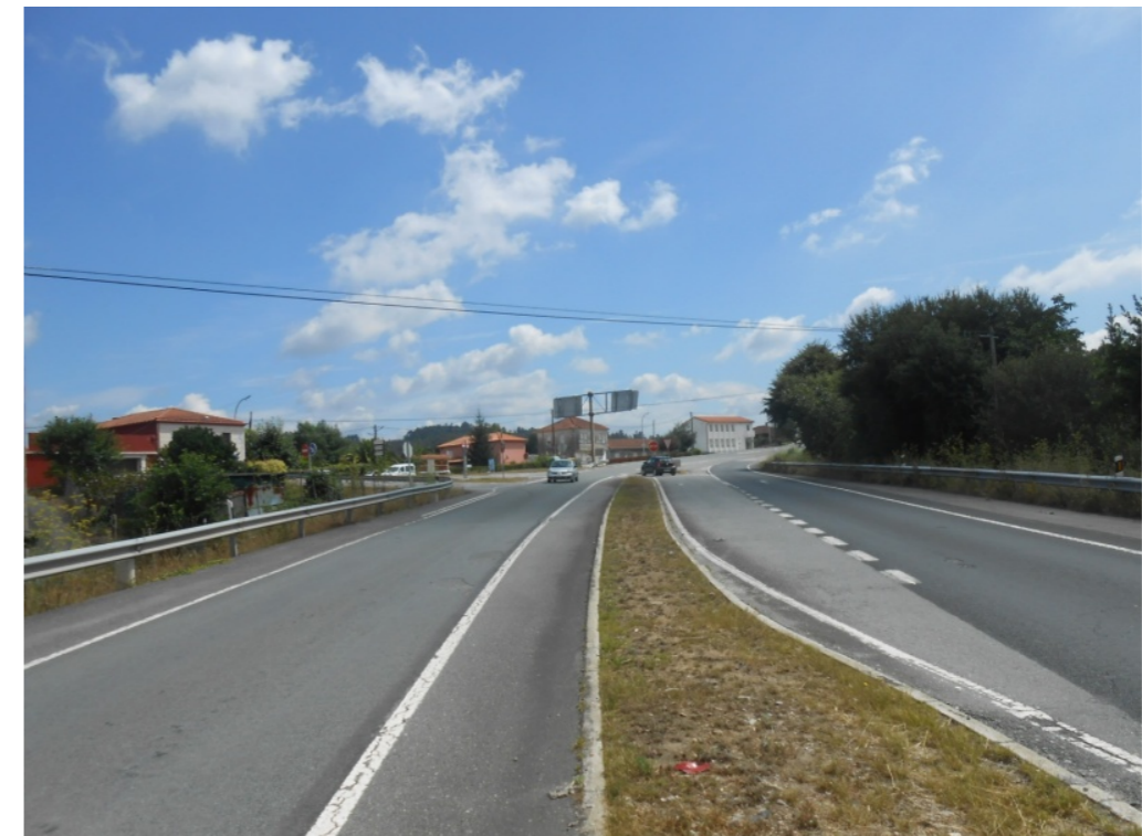
Vista de la Intersección N-VI y N-VIA, Fotografía desde carril central, de la N-VI PK 570+400, sentido decreciente
