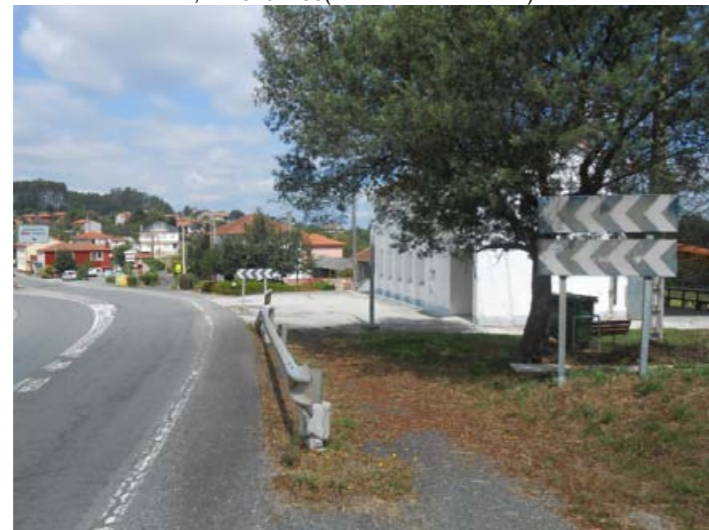
Vista N-Via, margen derecha,, sentido creciente , PK 579+260(Sistema de contención IPN)
