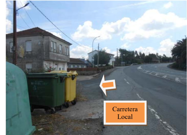
Vista N-Via, margen derecha, sentido decreciente, PK 579+300( Se aprecian cubos de basura, a la altura del acceso a carretera local)
