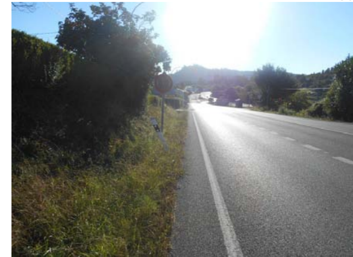
Vista de la N-VIa. P.K .579+740, Sentido decreciente. Lugar escogido para la implementación de un carril central de espera.
