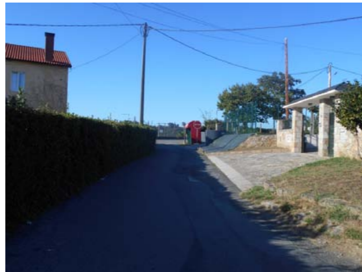
Vista Intersección ( Armea P.K.579+400 M.D. de la N-VIa, desde el propio acceso
