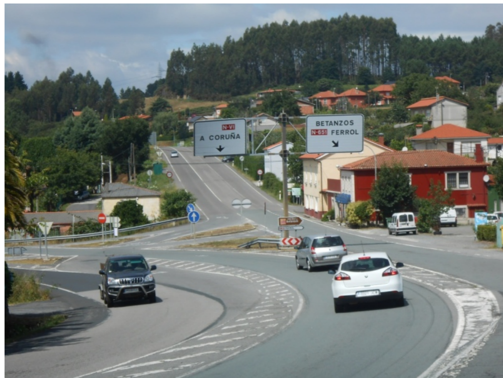
Vista de la Intersección N-VI y N-VIA, Fotografía desde la MD de la N-VI PK 570+280, sentido creciente
