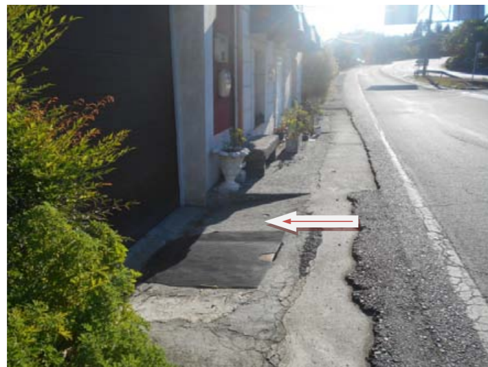
Vistas de viviendas en la N-VIa, margen derecha, Se aprecia el acceso deprimido a viviendas entre los PKs 579+360 al 579+400 Se puede apreciar también la presencia de garajes, con acceso directo a la N-VIa
