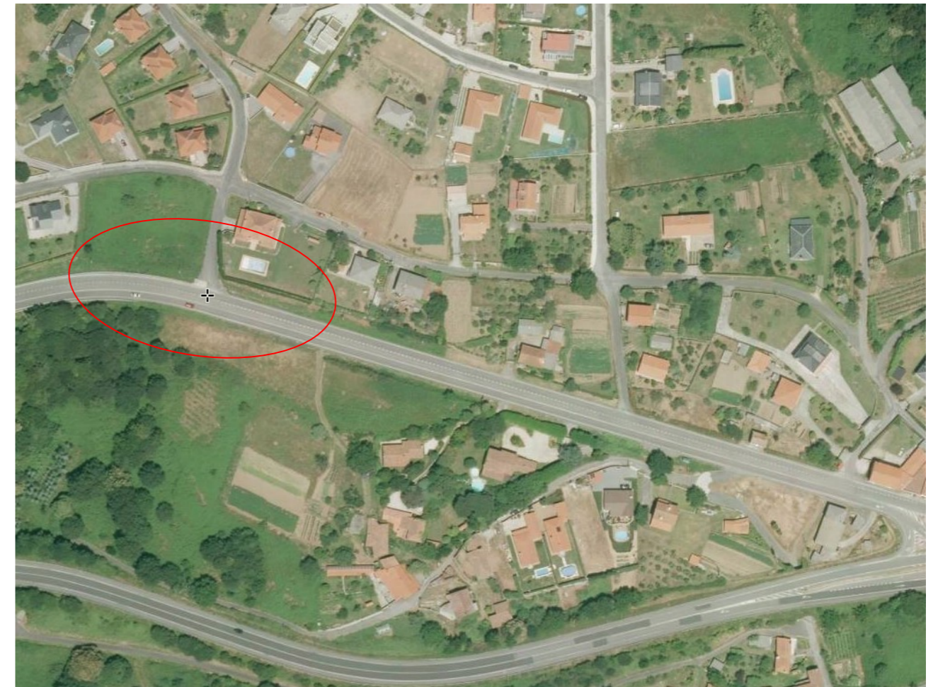
Vista aérea N-VIA, en la misma se puede apreciar el lugar escogido para la ejecución de un carril central de espera PK 579+740
