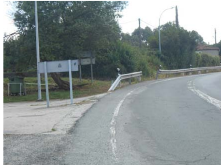
Vista N-Via, margen derecha,, sentido decreciente , PK 579+280(Acceso centro social)
