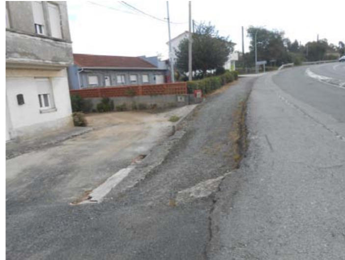
Vista N-Via, margen derecha, sentido decreciente , PK 579+280(Vista acceso deprimido a finca particular)
