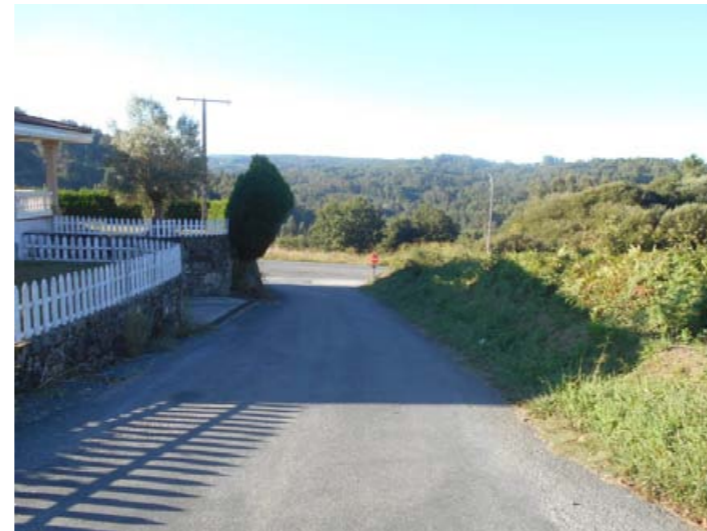
Vista Intersección, P.K .579+7400 M.D de la N-VIa. Acceso a Armea. Vista desde el Acceso
