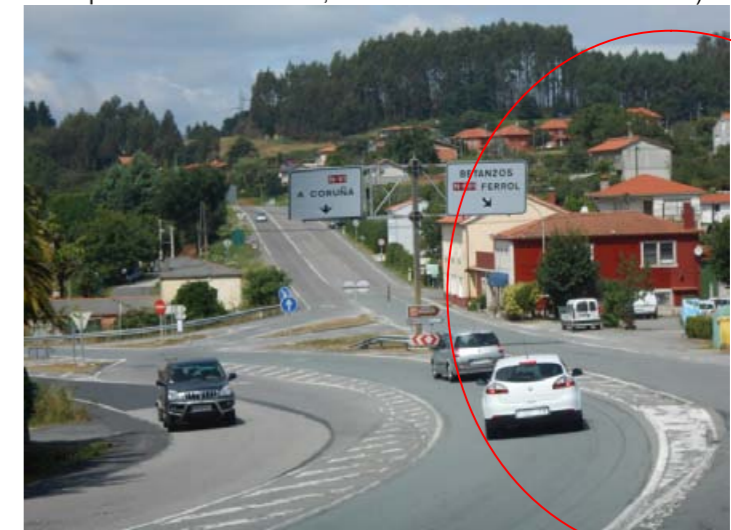
Vista desde N-VI, margen derecha, sentido creciente, PK 570+280( Se aprecia el acceso directo a Casa Maruja desde La N-Via (Sin ordenar)
