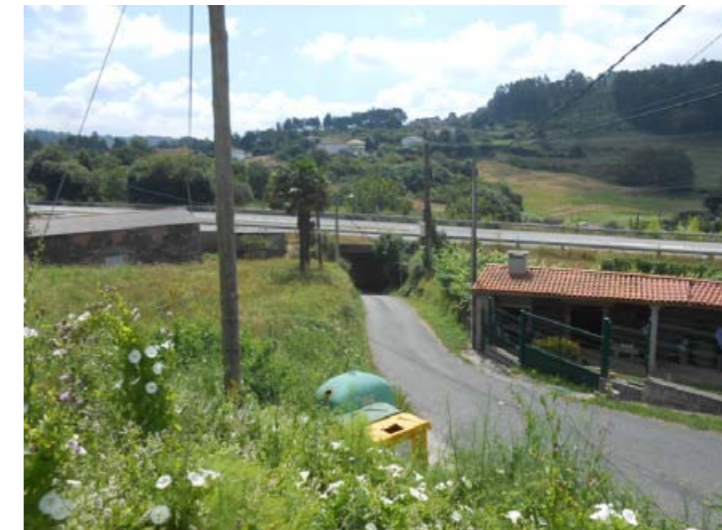
Vista del paso inferior sobre la N-VI, Pk570+420, conecta la N-VI con la N-VIa. Acceso a O Mende .
