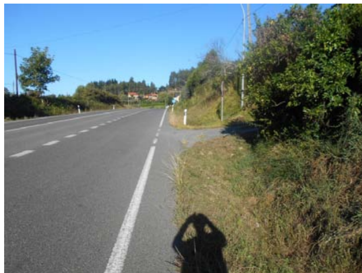
Vista Intersección, P.K .579+520 M.D de la N-VIa.
