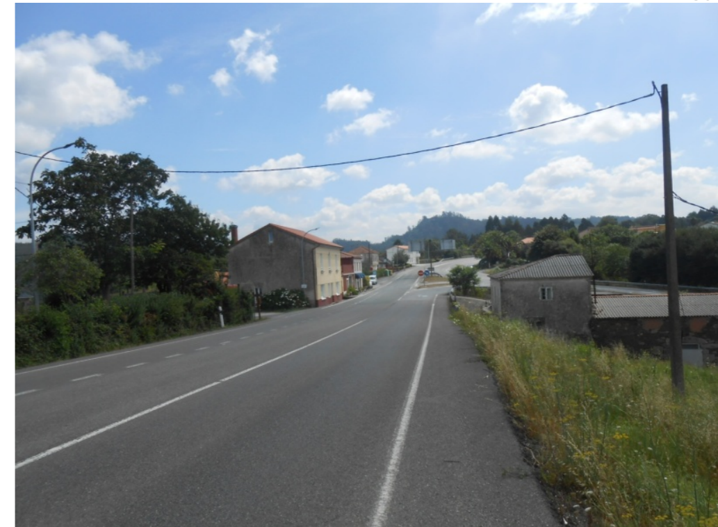
Vista de la Intersección N-VI y N-VIA, Fotografía desde la MI, de la N-VIA PK 579+440, sentido decreciente
