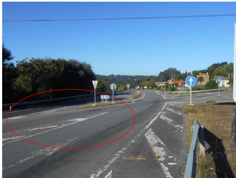
Vista de la Intersección N-VI y N-VIA, Fotografía desde la Isleta de la N-VIA Se aprecia el cayado, carril central espera en decreciente
