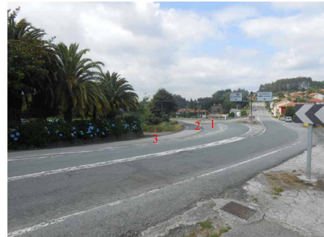
Vista de la Intersección O Mende PK 570+280, de la N-VIA en M.I, Fotografía la M.D. DE la N-VIA Se aprecia un punto de conflicto como consecuencia de la presencia de
