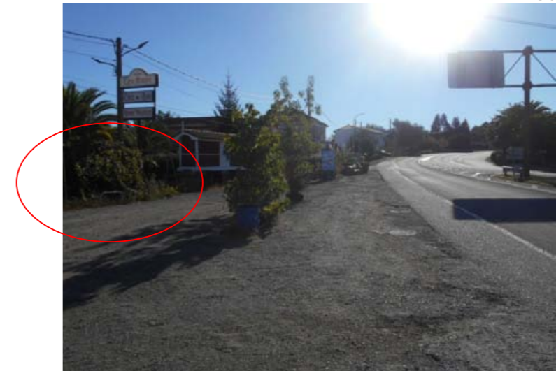
Vista del aparcamiento con acceso directo a la N-VI, En rojo aparece El punto escogido para realizar un nuevo acceso a la carretera local
