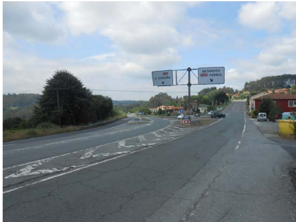
Vista de la Intersección N-VI y N-VIA, Fotografía desde la MD de la N-VIA PK 579+300, sentido creciente
