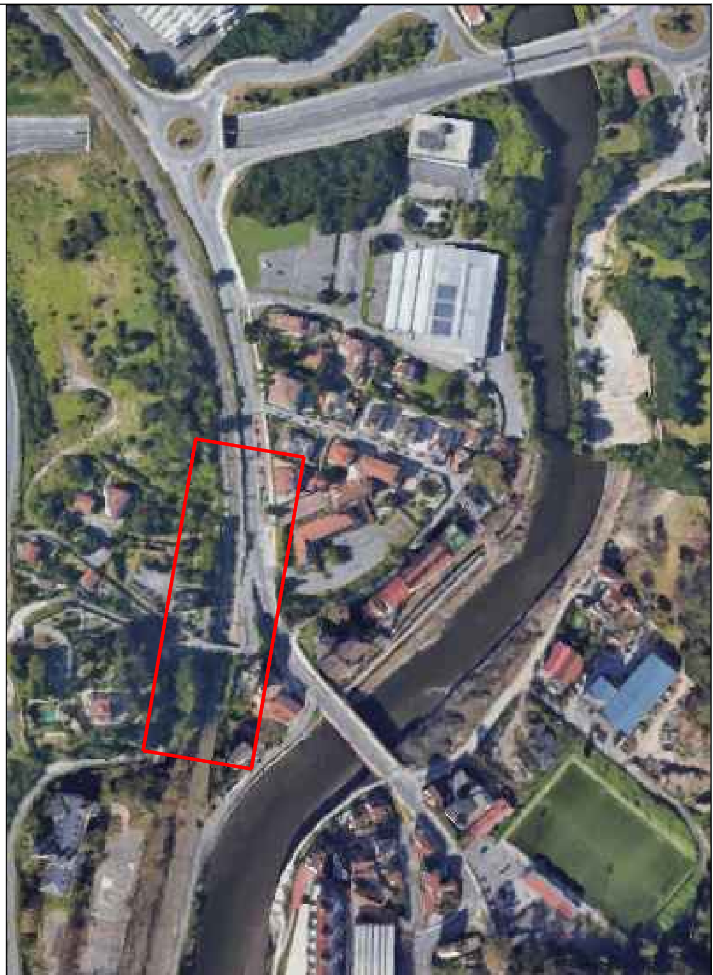
VISTA AÉREA DE LA ESTACIÓN DE MARTUTENE (Fuente: Google Earth)
