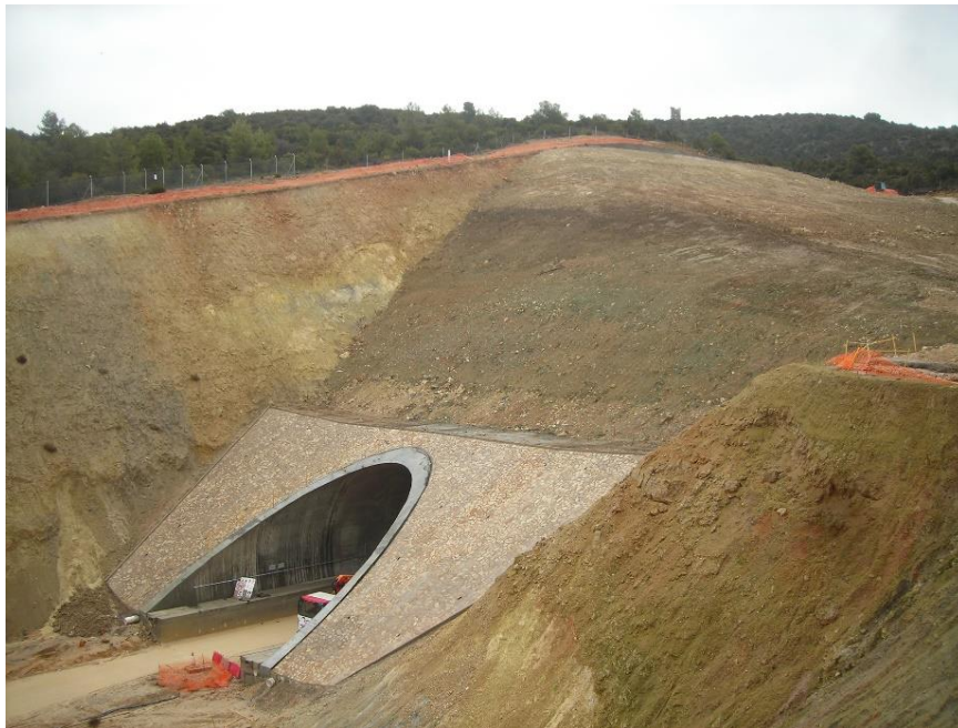
Ejemplo de boca de túnel rematada en “pico de flauta” y con relleno de escollera cementada.
