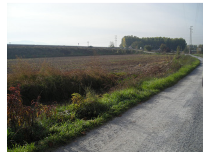
Fotografía 5. Terraplén existente en la A-92G, antes del puente de Los Vados.
