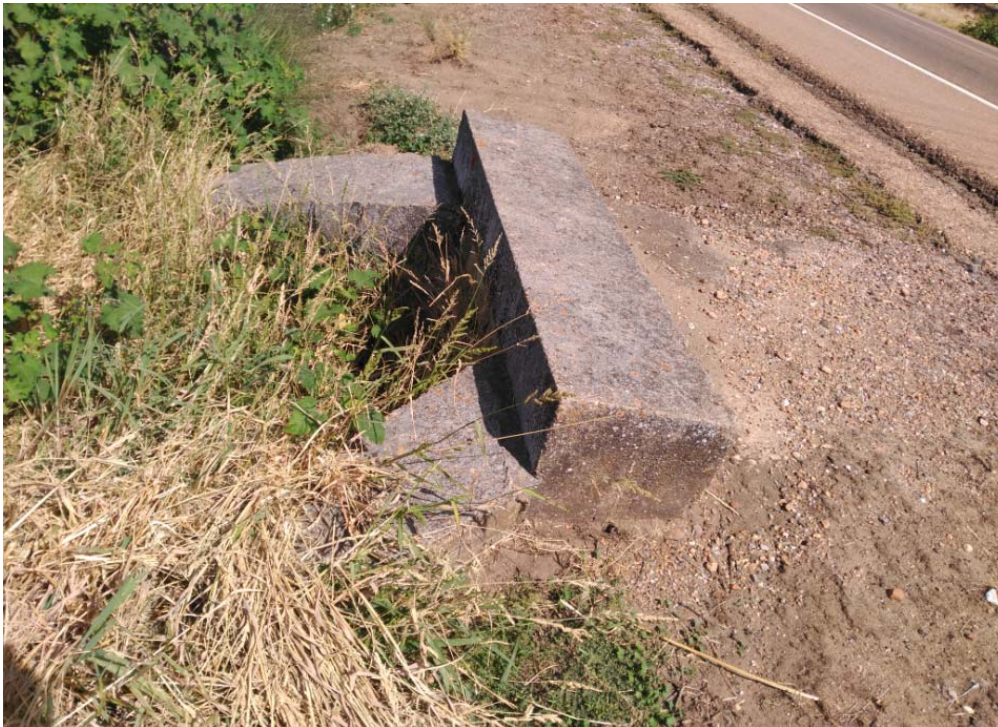
Imagen. Vista de la embocadura en el margen derecho de la calzada
