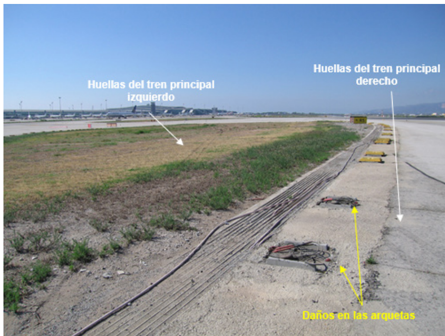
Fotografía 3: Daños en las arquetas y huellas del recorrido de la aeronave visto en el sentido de trayectoria de la aeronave
