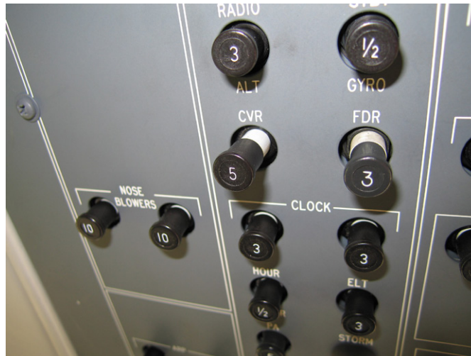
Fotografía 12: Fotografía del estado de los breakers de los registradores de vuelo.
