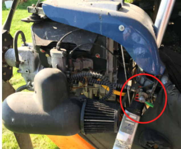
Figura 3. Válvula selectora de combustible
