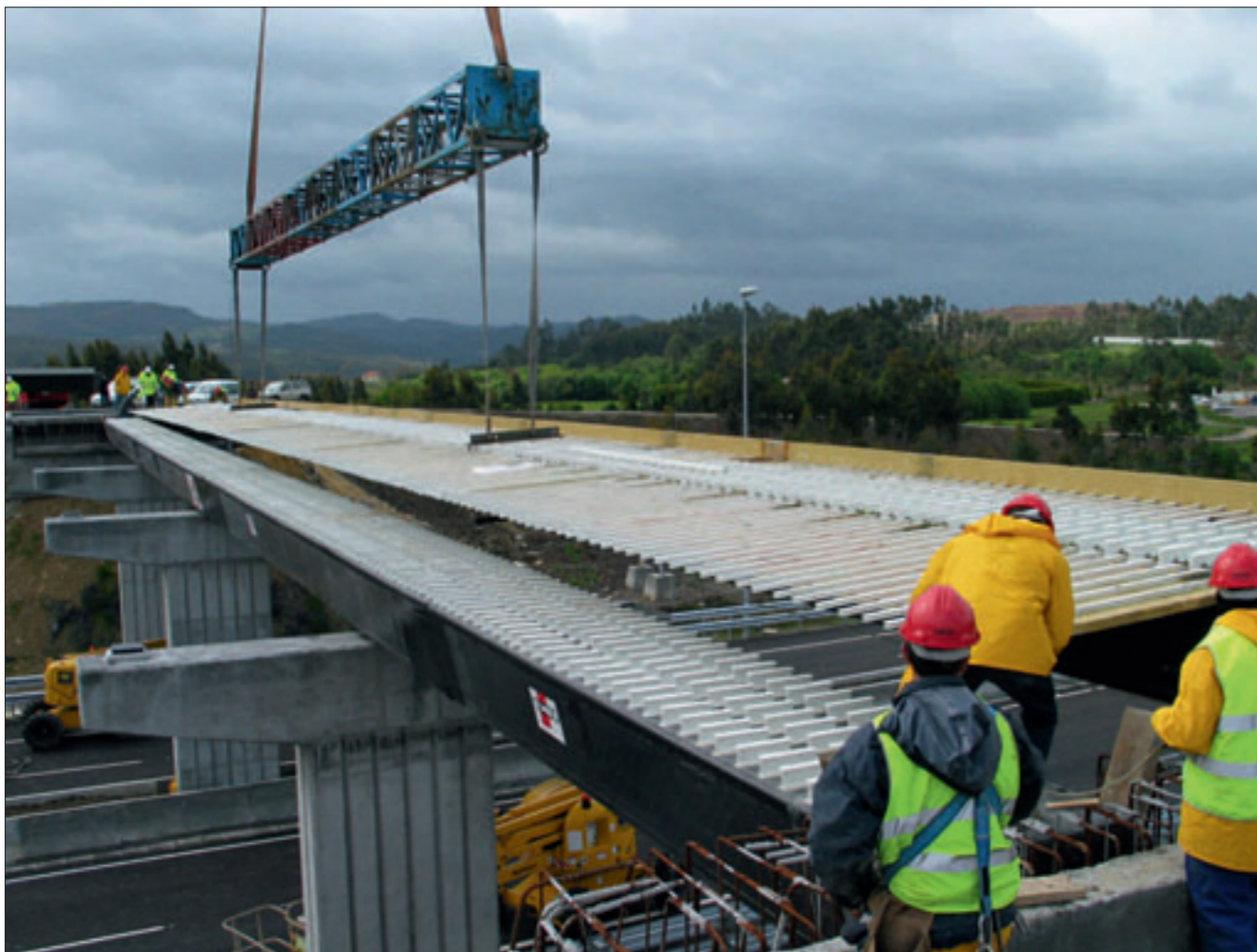
Colocación de las vigas sobre los pilares y estribos en el paso superior de la autovía del Cantábrico en Asturias.
