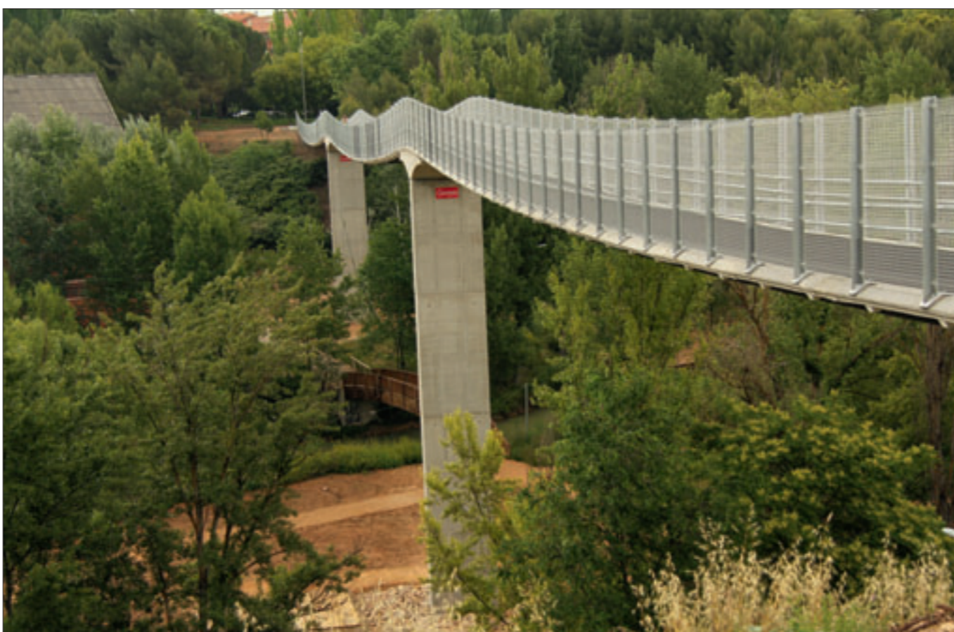
► Paso superior sobre la A-8 (arriba) y pasarelas sobre el Júcar en Cuenca y de Madrid Río, ejemplos de puentes basados en polímeros.
