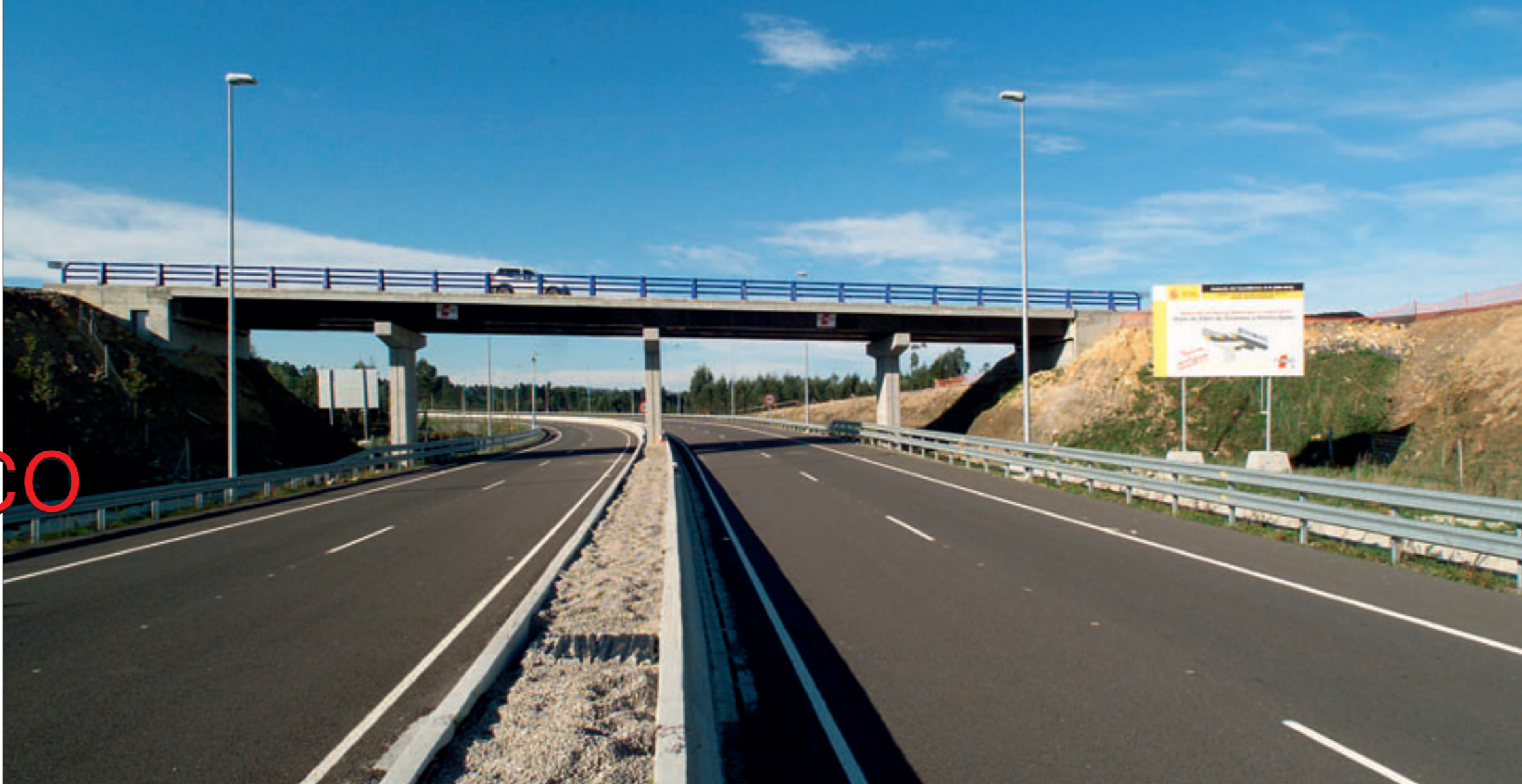
► Paso superior sobre la A-8 (arriba) y pasarelas sobre el Júcar en Cuenca y de Madrid Río, ejemplos de puentes basados en polímeros.
