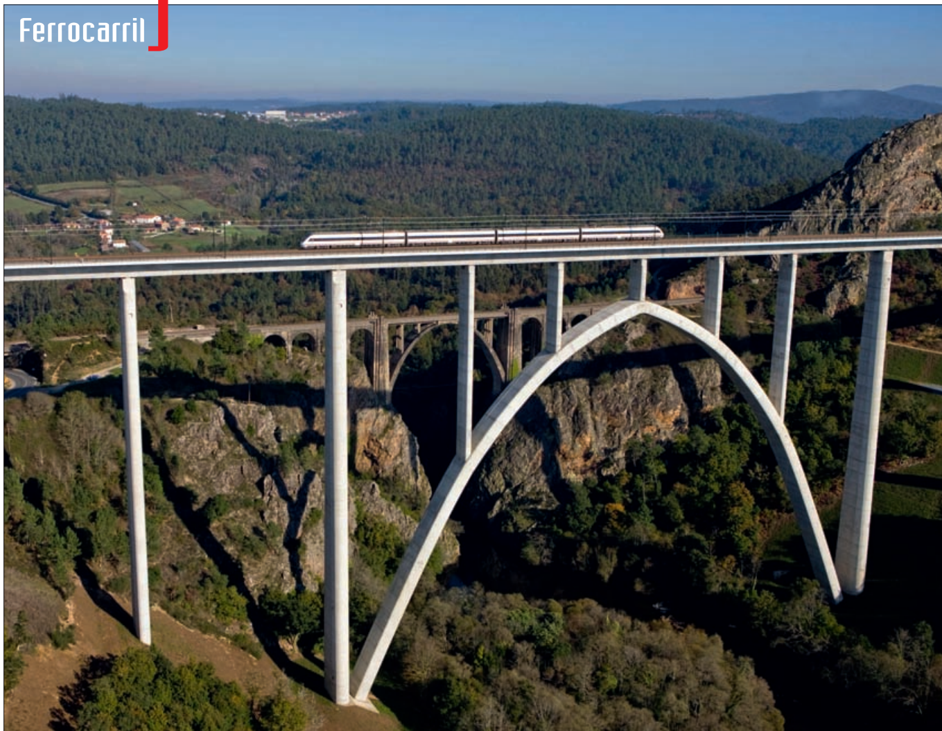
► Un tren S 121 circula por el viaducto sobre el río Ulla, icono de la nueva línea.
