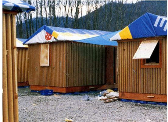
La cubierta de lona, sujeta a una cercha igualmente de cartón, se puede retirar y separarse en verano para permitir la ventilación.
