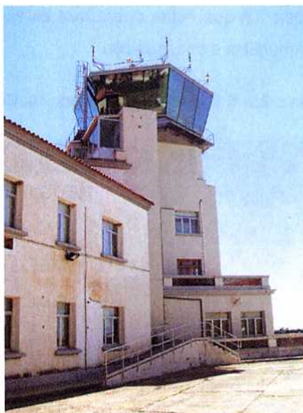
Ilustración 2.17.- Torre de Control
