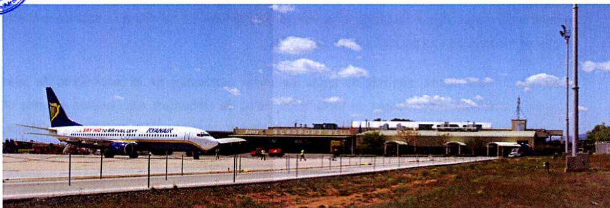
Ilustración 2.10.- Acceso a plataforma desde el Edificio Terminal de Salidas
