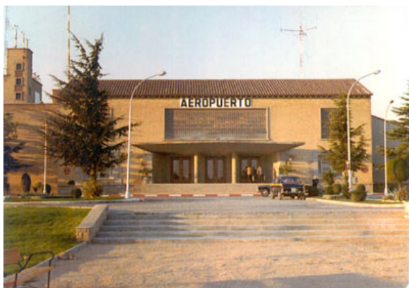
Ilustración 1.1.- Fachada del lado tierra del antiguo edificio terminal
