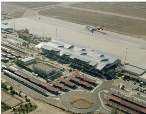
Ilustración 1.2.- Imagen panorámica del Aeropuerto de Zaragoza. Año 2009.
