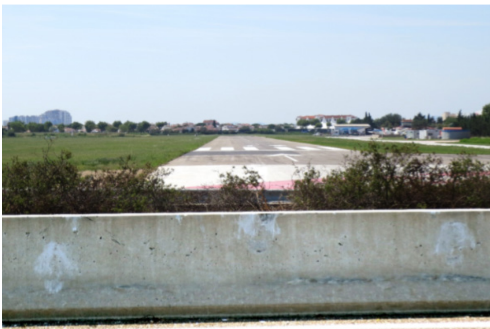
Figura 3. Detalle de huellas de impacto de tren de aterrizaje en mediana
