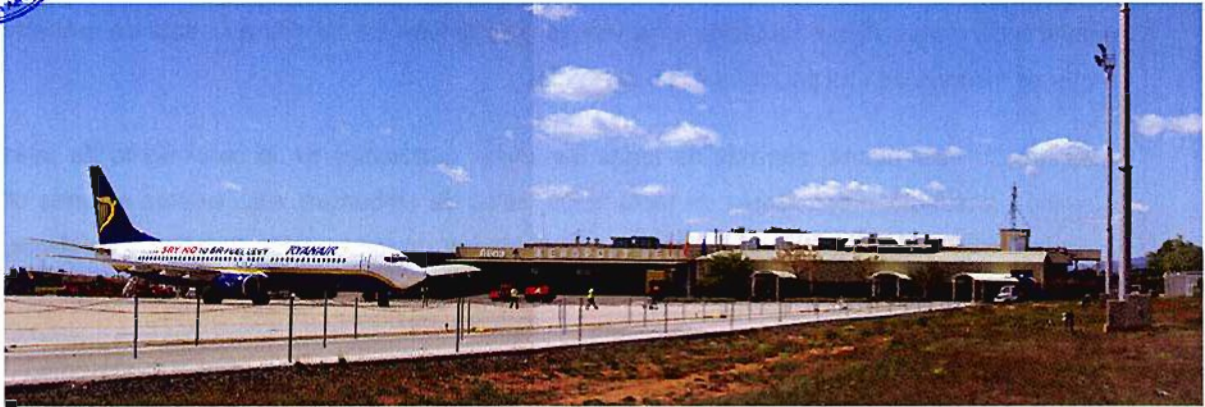
Ilustración 2.10.- Acceso a plataforma desde el Edificio Terminal de Salidas
