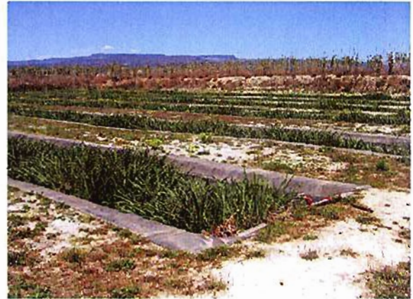
Ilustración 2.24.- Depuradora biológica y canales de macrofitas
