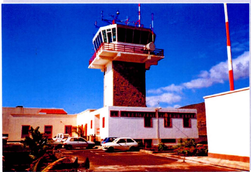
GRÁFICO 2.XII. BLOQUE TÉCNICO Y TWR. FACHADA NORTE BLOQUE TÉCNICO. FACHADA SUR (COCHERAS)
