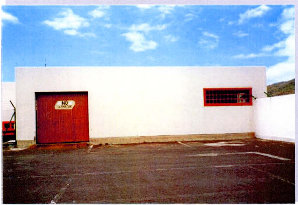
GRÁFICO 2.XX. EDIFICIO DE IBERIA. FACHADA NORTE EDIFICIO DE IBERIA. FACHADA SUR
