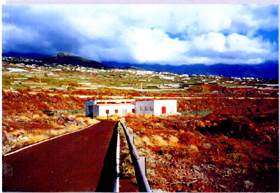
GRÁFICO 2.XXXIII. CENTRAL ELÉCTRICA. FACHADA ESTE CENTRAL ELÉCTRICA. FACHADA OESTE
