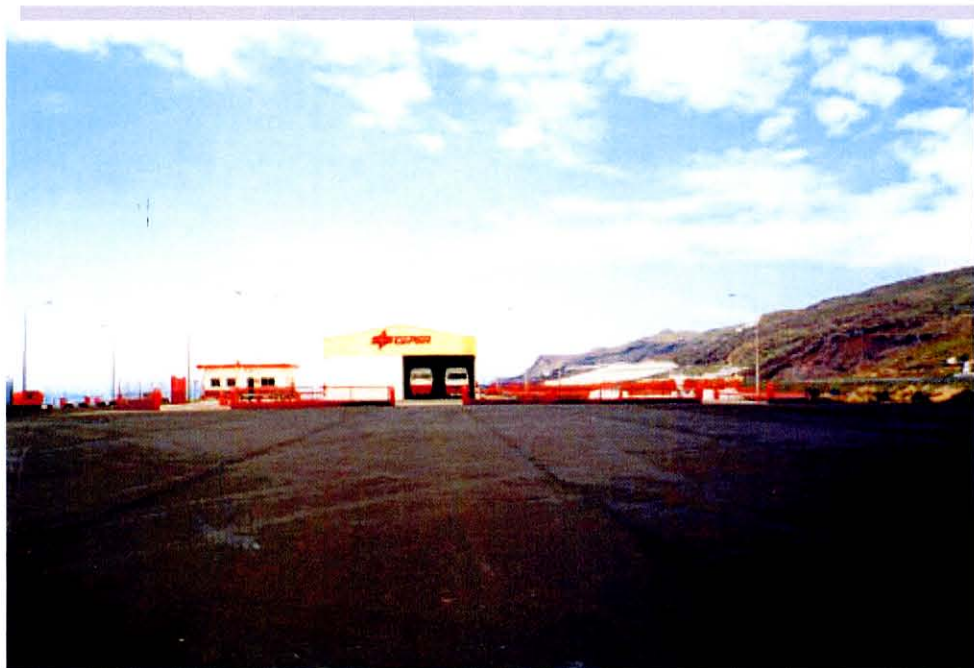
GRÁFICO 2.XXX. INSTALACIONES DE COMBUSTIBLES. FACHADA NORTE INSTALACIONES DE COMBUSTIBLES. FACHADA SUR
