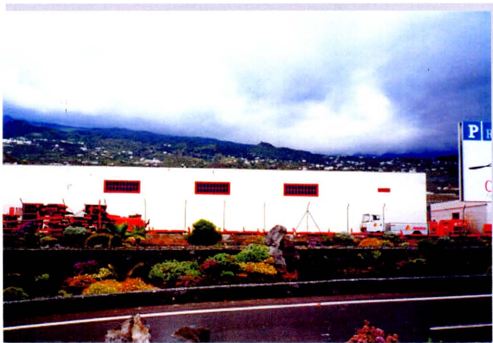
GRÁFICO 2.X. EDIFICIO TERMINAL DE CARGA. FACHADA ESTE EDIFICIO TERMINAL DE CARGA. FACHADA OESTE (LADO TIERRA)
