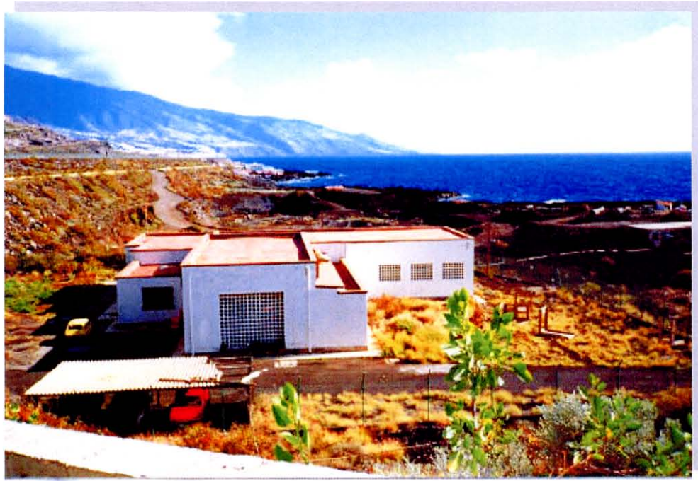
GRÁFICO 2.XXXII. CENTRAL ELÉCTRICA. FACHADA SUR CENTRAL ELÉCTRICA. FACHADA NORTE
