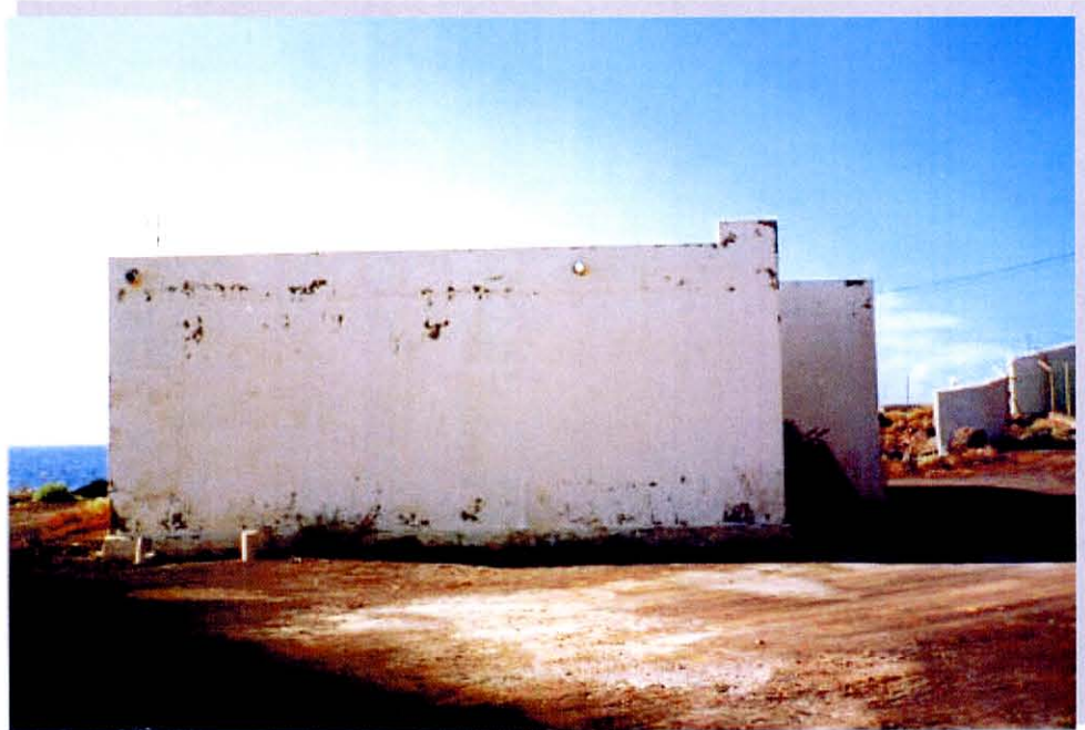
GRÁFICO 2.XXIV. LABORATORIO. FACHADA NORTE LABORATORIO. FACHADA SUR
