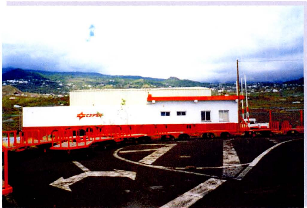
GRÁFICO 2.XXXI. INSTALACIONES DE COMBUSTIBLES. FACHADA ESTE INSTALACIONES DE COMBUSTIBLES. LADERA OESTE
