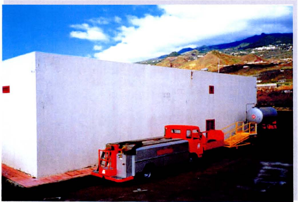
GRÁFICO 2.XI. EDIFICIO TERMINAL DE CARGA. FACHADA NORTE EDIFICIO TERMINAL DE CARGA. FACHADA OESTE SUR (MUELLE)
