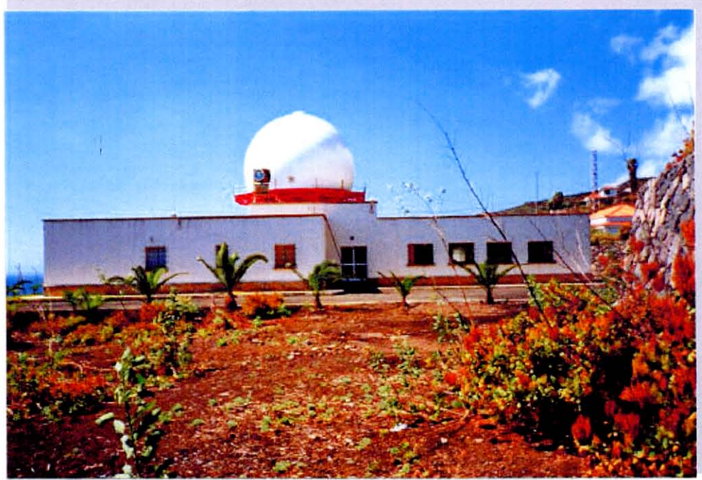
GRÁFICO 2.XVI. CENTRO DE EMISORES. FACHADA NORTE CENTRO DE EMISORES. FACHADA SUR
