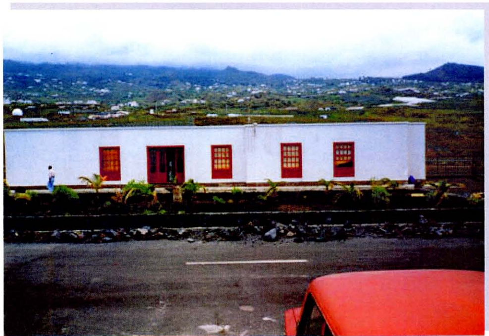
GRÁFICO 2.XXIII. ALMACÉN. FACHADA ESTE ALMACÉN. FACHADA OESTE (LADO AIRE)
