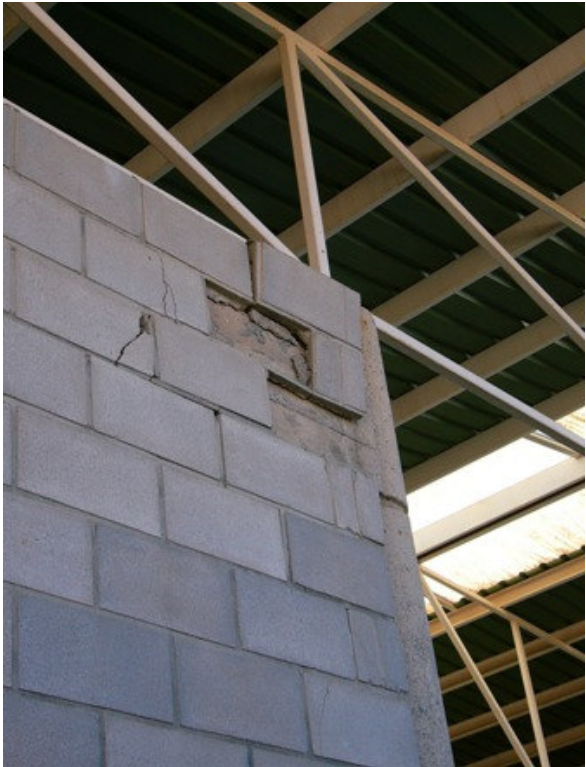
Daños a cerramientos de bloque de hormigón causados por desplazamiento de la estructura
