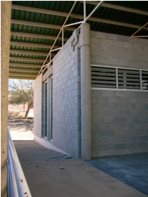
Daños a cerramientos de bloque de hormigón causados por desplazamiento de la estructura
