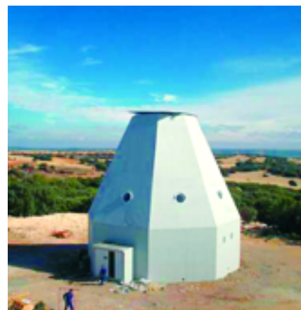
Torre de control.
