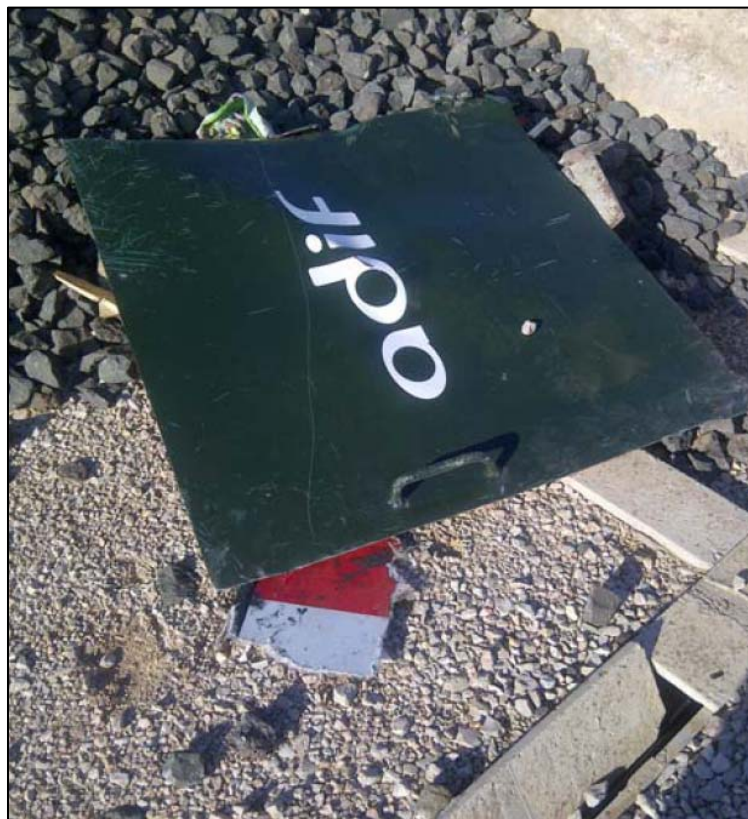
Cartel de peligro arrollado. Fuente Adif
