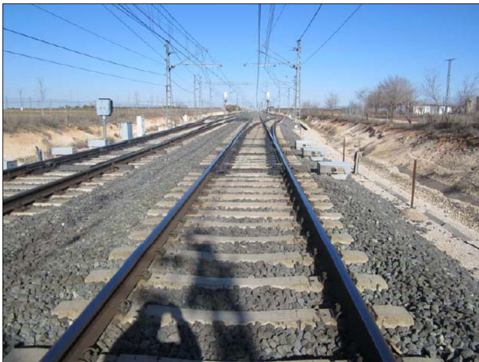
Vista del desvío nº 8. Fuente: Adif
