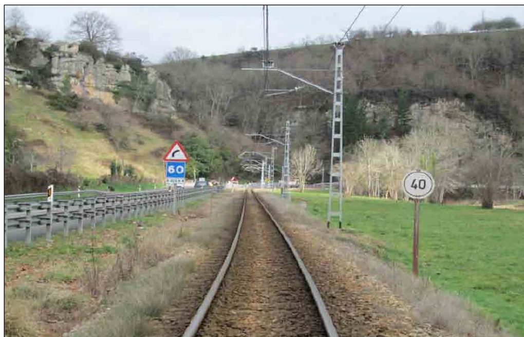
Señal de anuncio de L.P.V. a 40 km/h antes del lugar del descarrilamiento.
